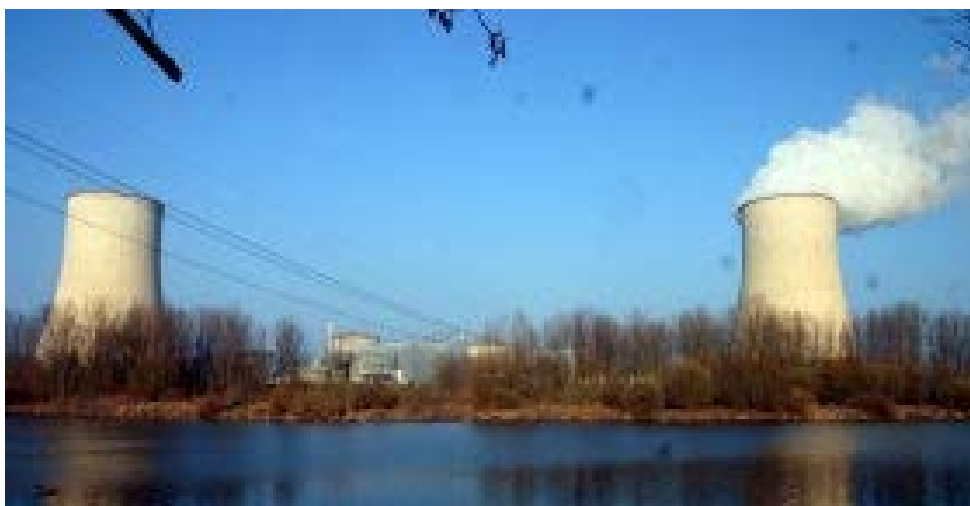
Figure 7 - Vue montrant les lignes électriques
